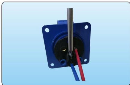
7. 把零线插进螺丝孔并拧紧螺丝
