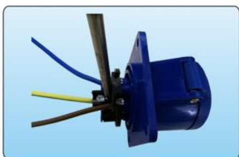
3.拧紧螺丝(对照图标接线)
