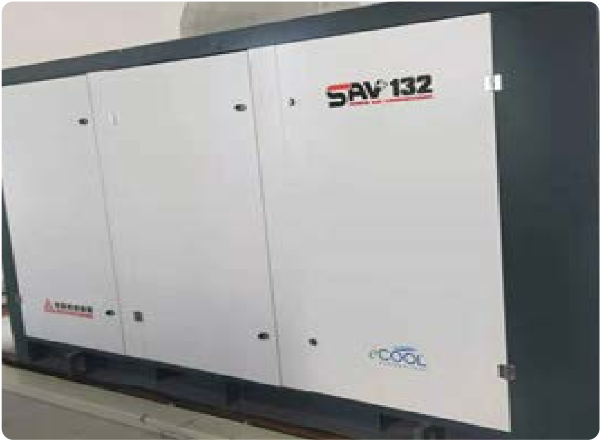
1) 投入 5 台节能型空压机 & 超级管道
