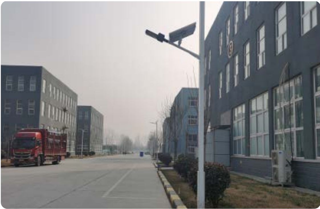
2) 太阳能路灯改造，共计更换 157 盏太阳能路灯
